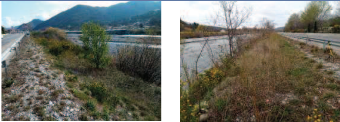
Figure 17 : Vue de la protection de berge existante à l'amont (gauche) et à l'aval (droite).
