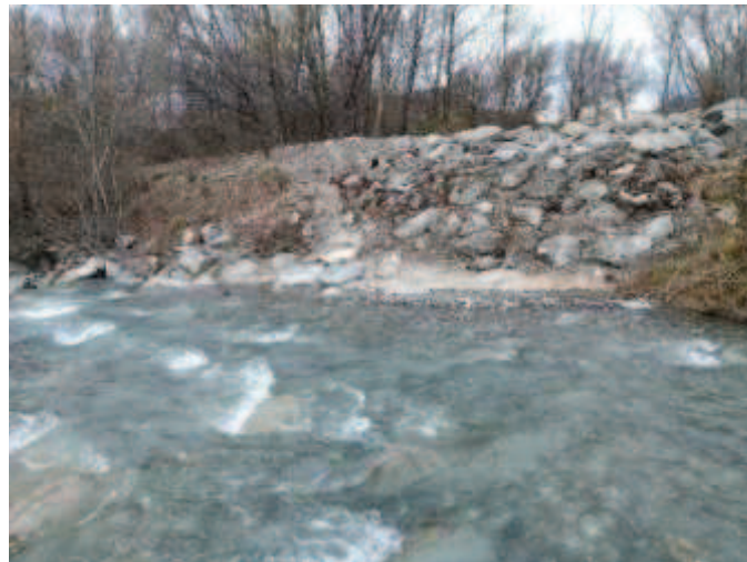
Figure 24 : Vue de la zone bétonnée, au droit du seuil.
