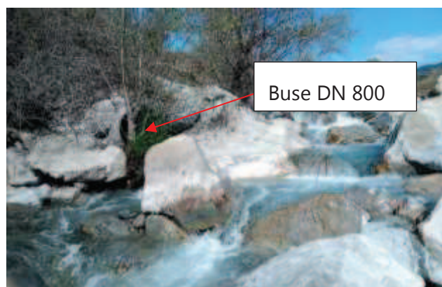
Figure 5 : Exutoire pluvial au droit du seuil des CFP.
